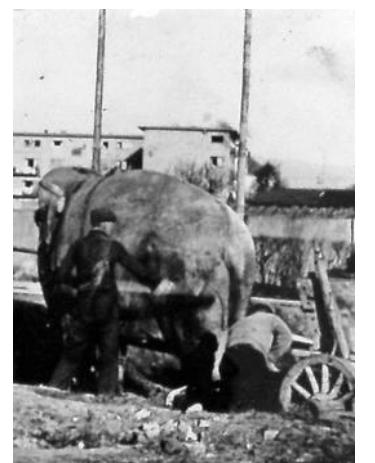
Bei Bauarbeiten wurde 1937 sogar ein Elefant eingesetzt.
