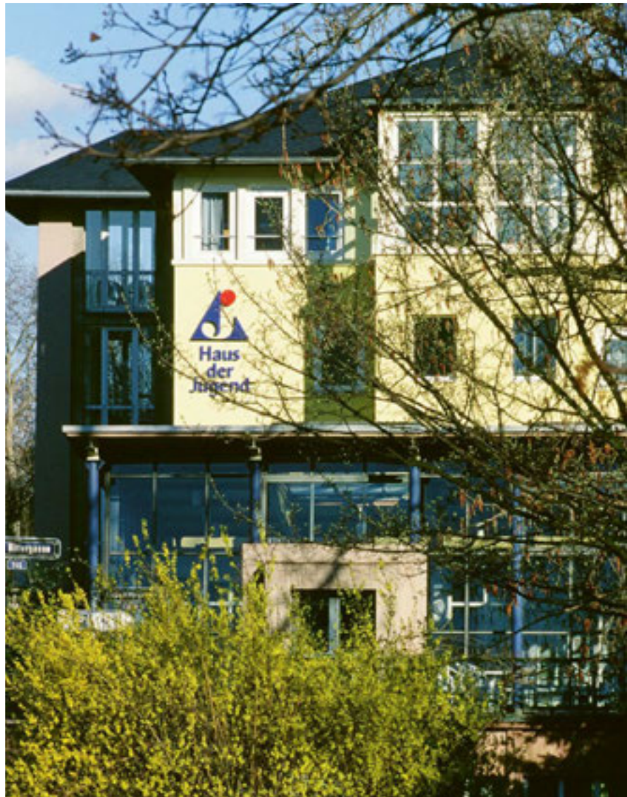
Haus der Jugend mit Glashausanbau
