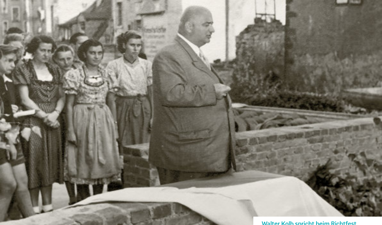
Walter Kolb spricht beim Richtfest
