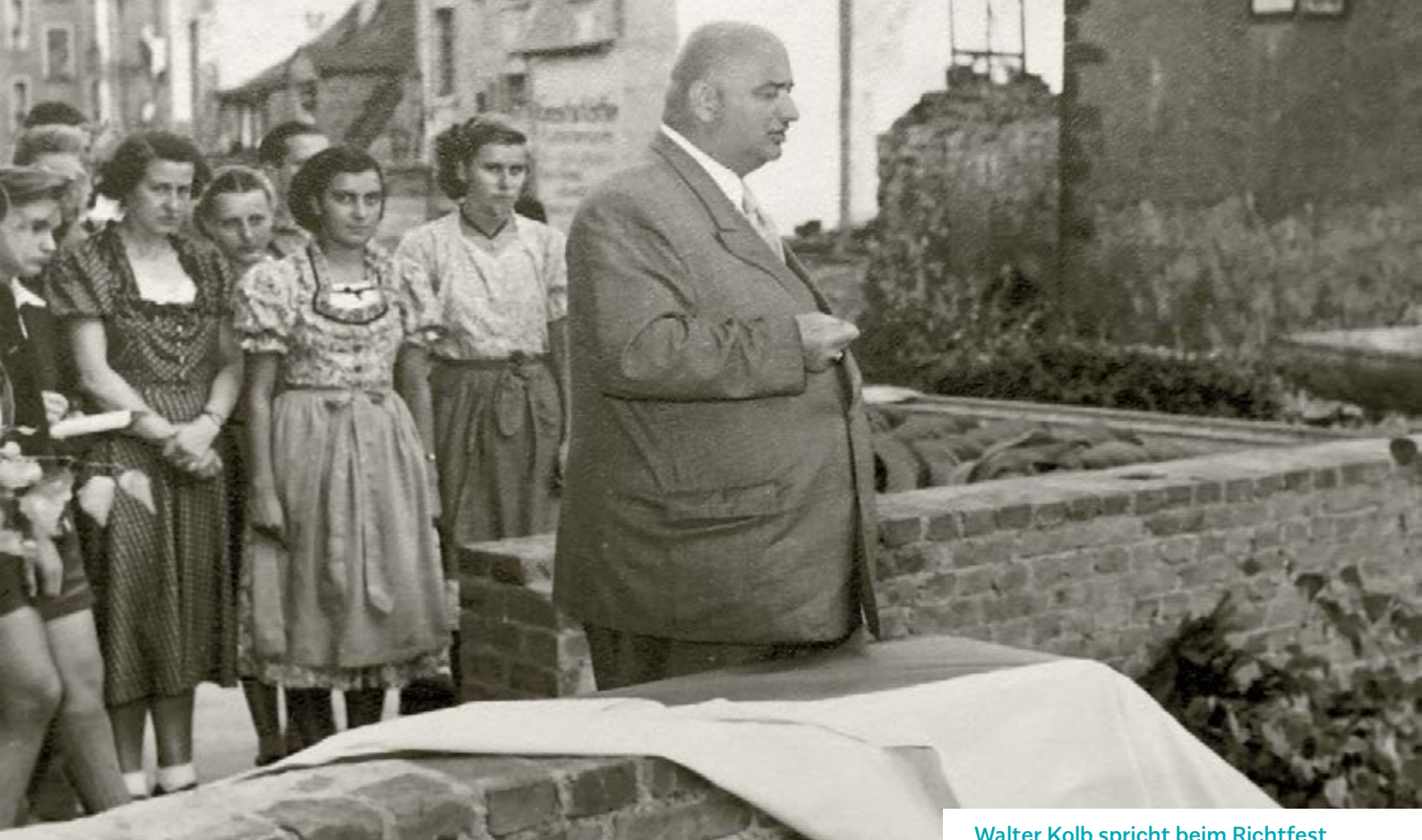
Walter Kolb spricht beim Richtfest
