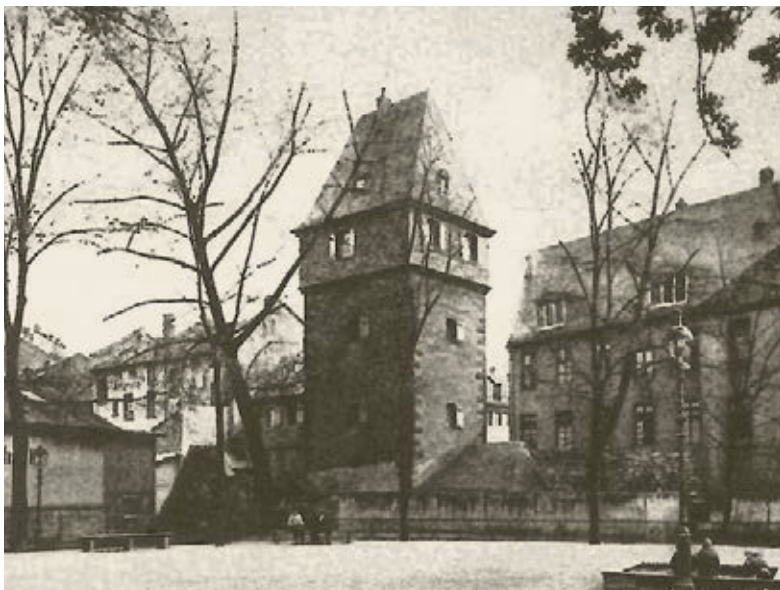
Der Bauplatz für das Haus der Jugend vor dem Kuhhirtenturm. Aufnahme um 1930
